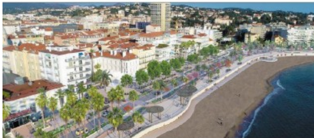
Jne vue de la future Promenade des bains après neuf mois de travaux.
